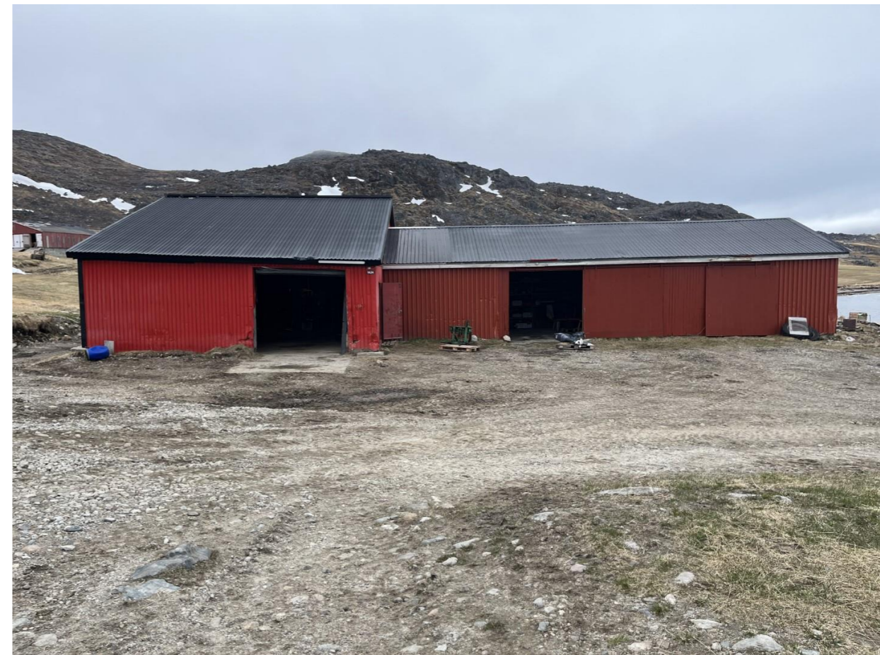
Eksisterende lager- og værkstedsbygning
